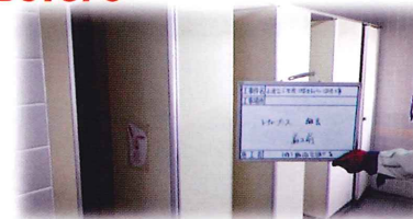
■小倉台小学校 女子トイレ改修工事
